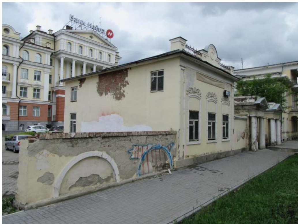
Фото 2. Вид на северный и западный фасады с ул. Чапаева. Июнь 2023.
