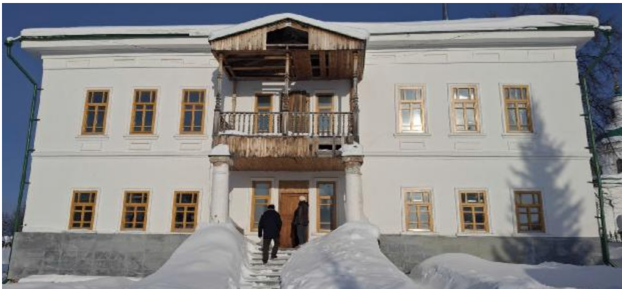
Фото 2. Южный фасад. Февраль 2026 г.
