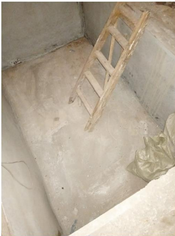
Монолитный приямок шахты лифта после выполнения противоаварийных работ. Фото 12.2025 г.
