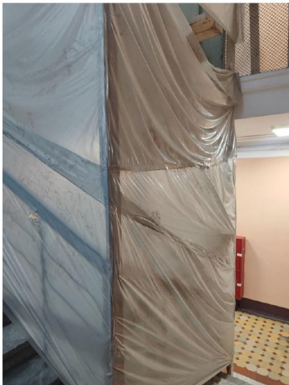
Вид на шахту лифта, обтянутую полиэтиленовой пленкой. Фото 12.2025 г.
