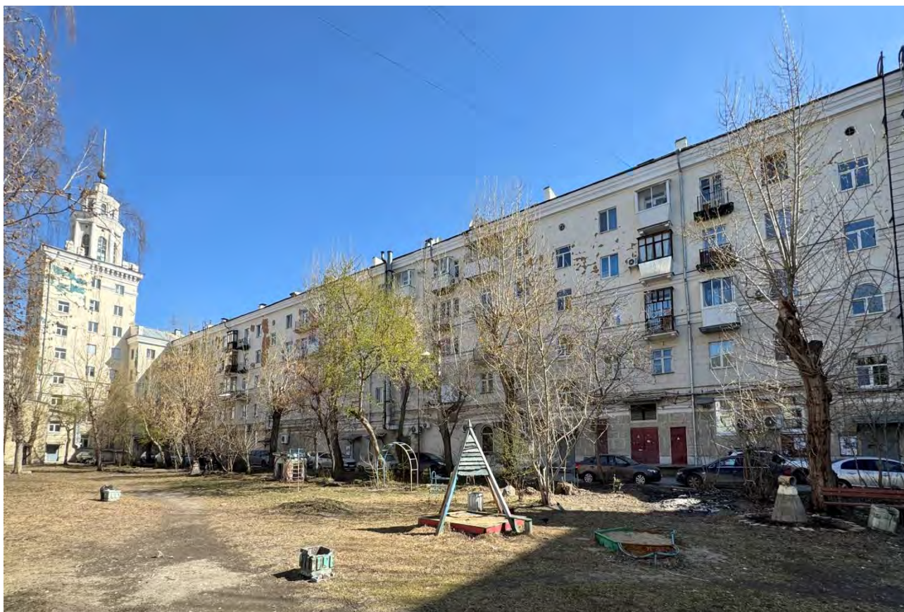
Илл. 17. Дворовый (западный) фасад памятника, обращённый к территории планируемой реконструкции, вид с юго-запада, апрель 2026 г.
