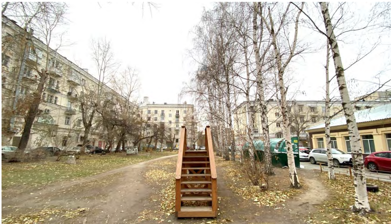
Илл. 19. Общий вид двора с северной стороны.
