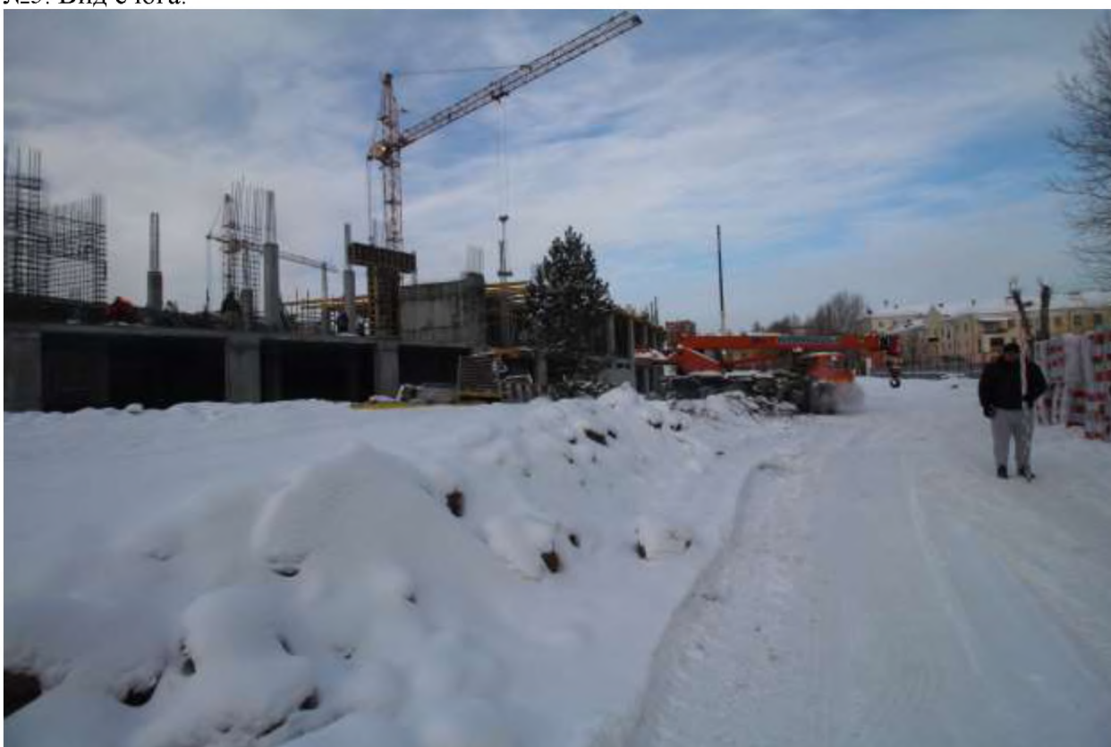
Рис. 21. Свердловская область, г. Первоуральск, ул. Физкультурников. Земельные участки с кадастровыми номерами 66:58:0113004:2060 и 66:58:0113004:2068. Точка фотофиксации №5. Вид с юго-востока.
