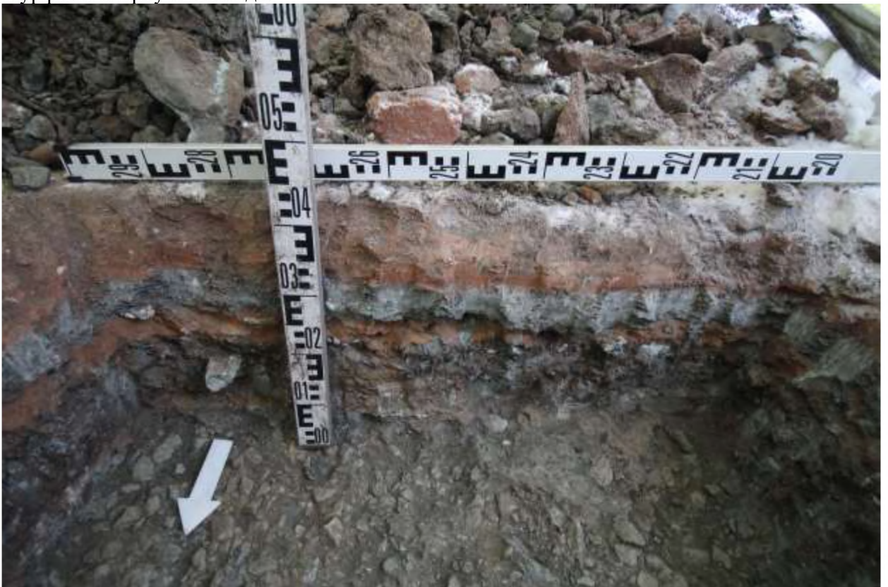
Рис. 33. Свердловская область, г. Первоуральск, ул. Физкультурников. Земельные участки с кадастровыми номерами 66:58:0113004:2060 и 66:58:0113004:2068. Вид на южный борт шурфа №2 с севера.
