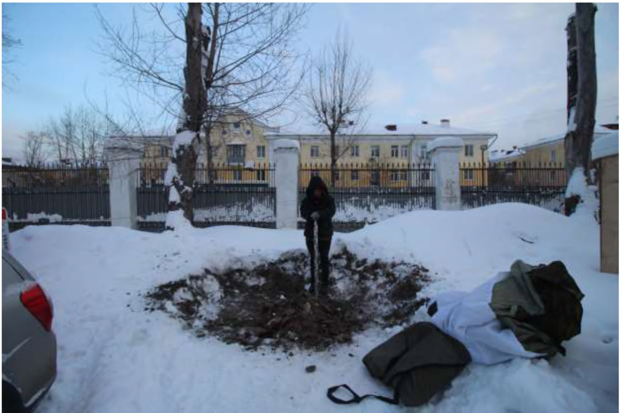
Рис. 34. Свердловская область, г. Первоуральск, ул. Физкультурников. Земельные участки с кадастровыми номерами 66:58:0113004:2060 и 66:58:0113004:2068. Шурф №2 после рекультивации. Вид с запада.
