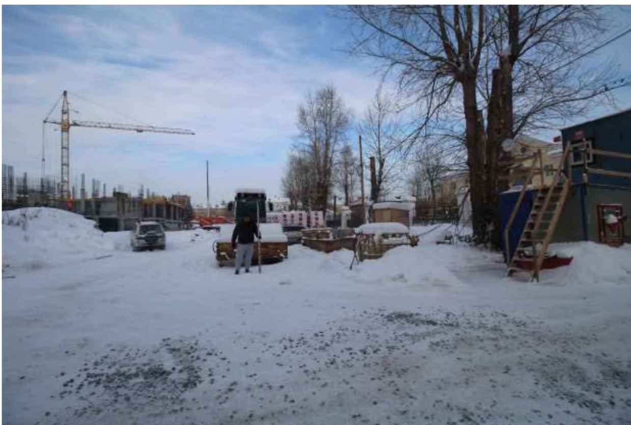
Рис. 14. Свердловская область, г. Первоуральск, ул. Физкультурников. Земельные участки с кадастровыми номерами 66:58:0113004:2060 и 66:58:0113004:2068. Точка фотофиксации №3. Вид с юга.
