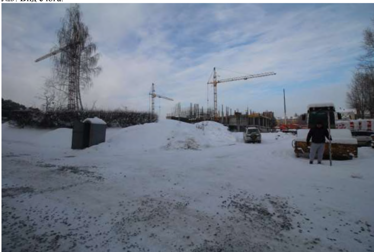
Рис. 15. Свердловская область, г. Первоуральск, ул. Физкультурников. Земельные участки с кадастровыми номерами 66:58:0113004:2060 и 66:58:0113004:2068. Точка фотофиксации №3. Вид с юго-востока.
