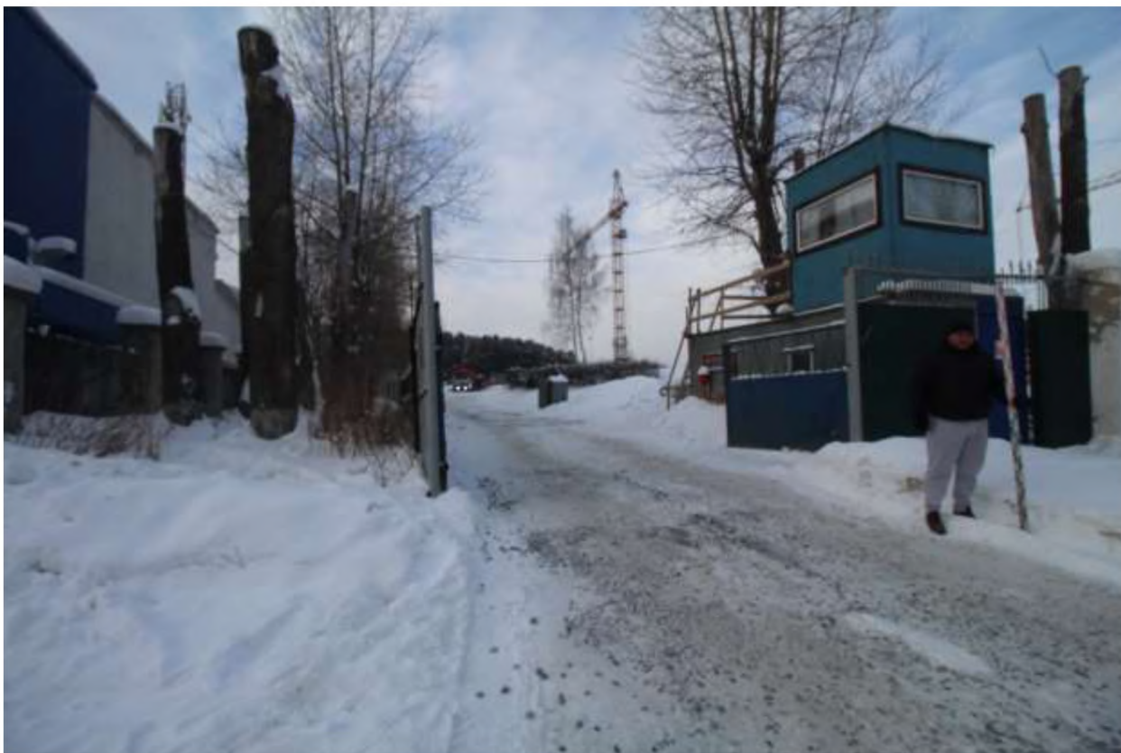
Рис. 18. Свердловская область, г. Первоуральск, ул. Физкультурников. Земельные участки с кадастровыми номерами 66:58:0113004:2060 и 66:58:0113004:2068. Точка фотофиксации №4. Вид с востока.
