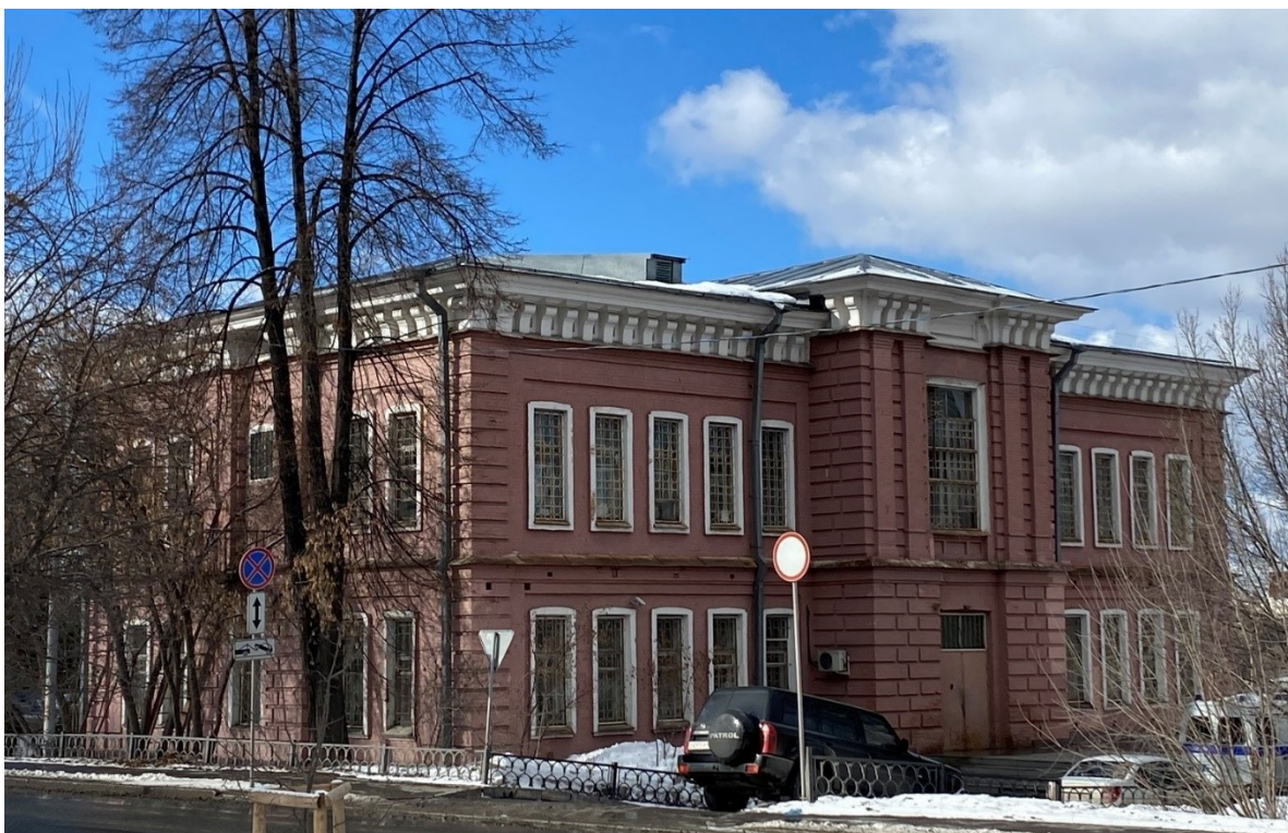
Фото 2. Объект культурного наследия регионального значения «Здание общественное» (г. Екатеринбург, Кирова ул., 2) [Источник: https://okn-mk.mkrf.ru/maps/show/id/5184883 Дата обращения 29.03.2026]
