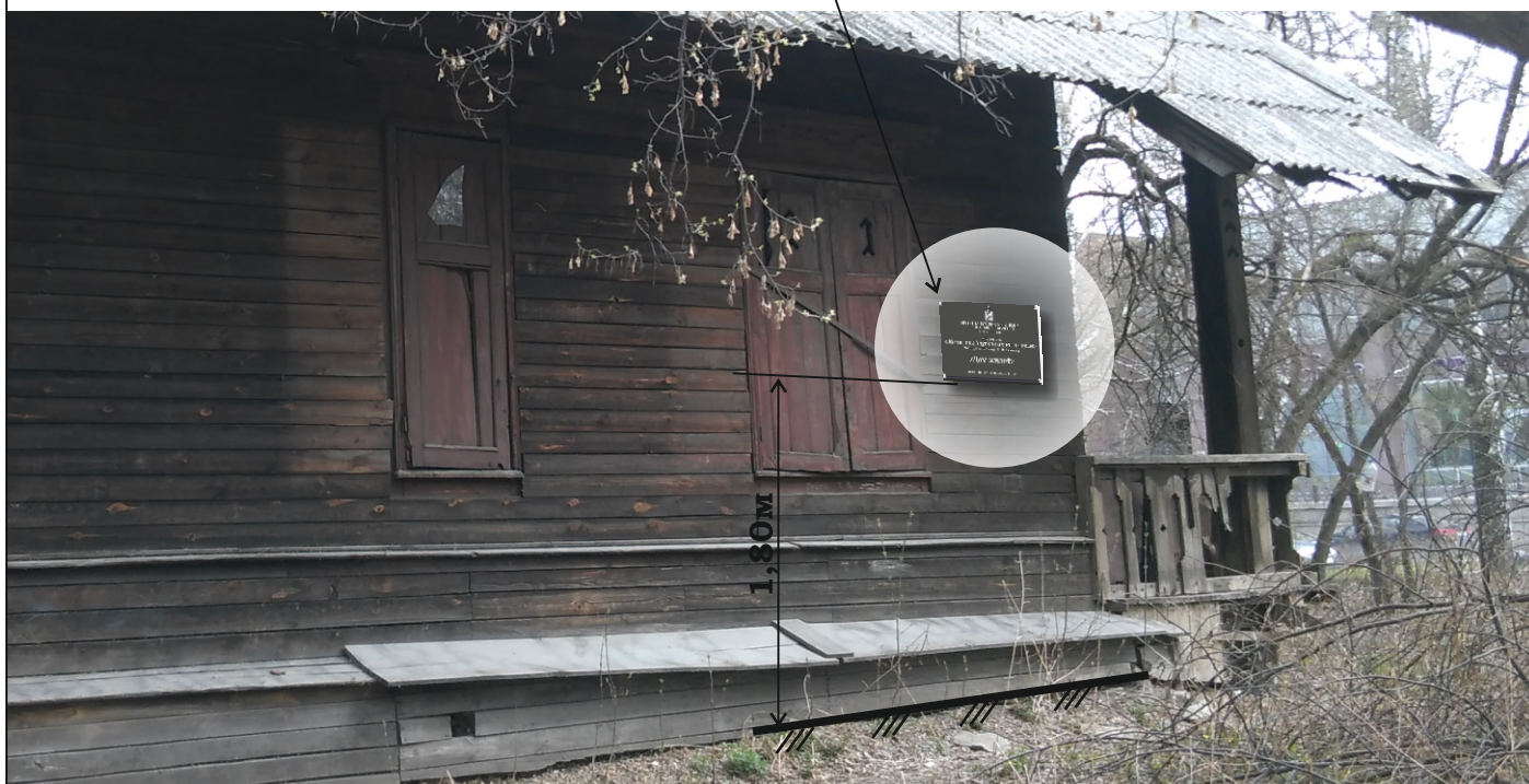
Фрагмент бокового фасада объекта (ул. Большакова, д. 84) со стороны ул. Шейнкмана
