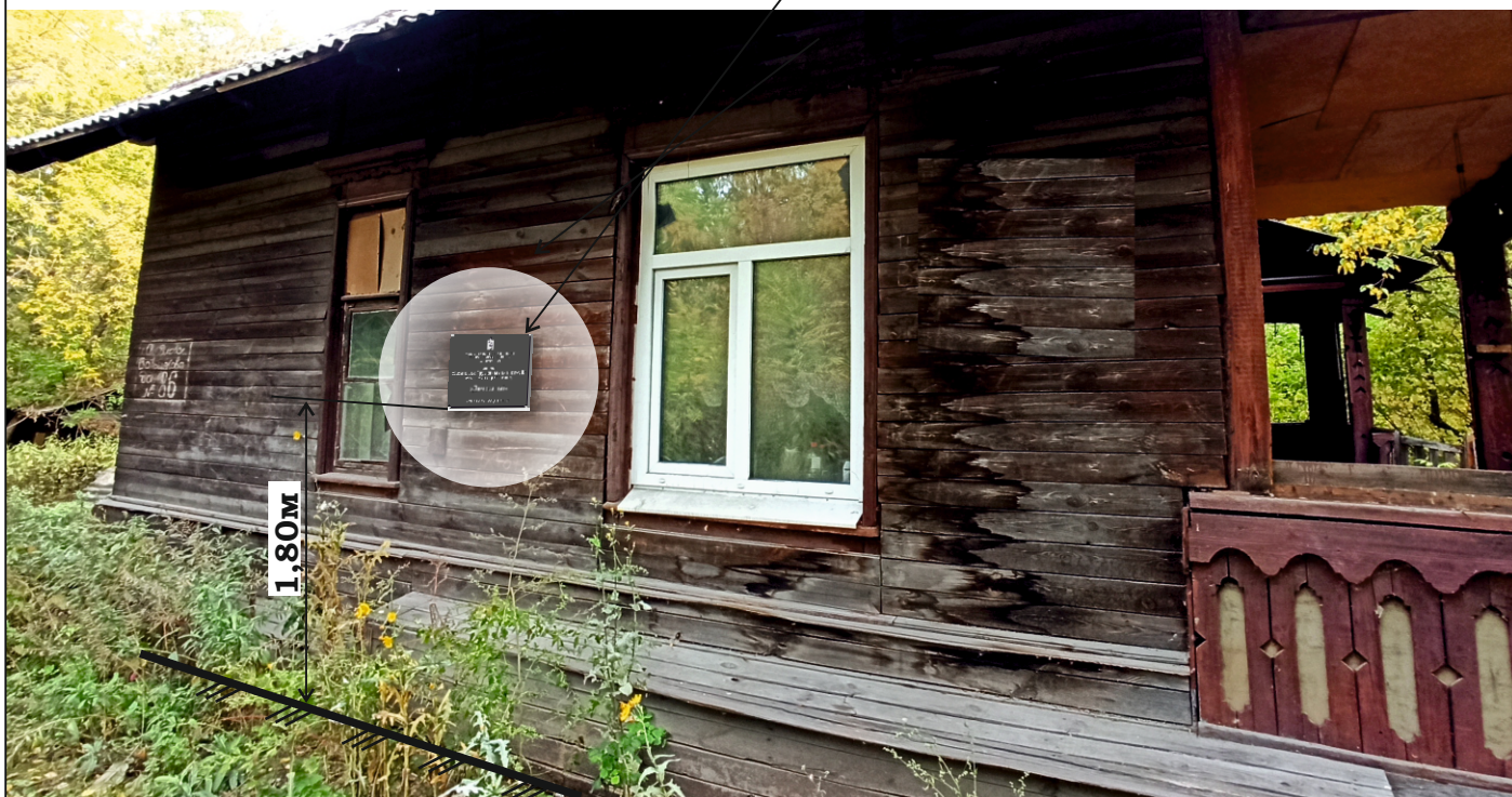
Фрагмент бокового фасада объекта (ул. Большакова, д. 86) со стороны ул. Шейнкмана
