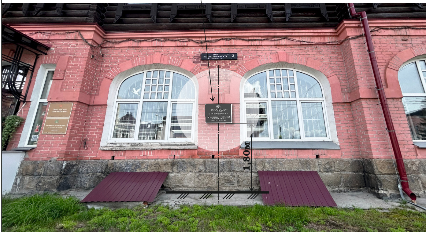
Фрагмент фасада объекта со стороны ул. Карла Либкнехта.
