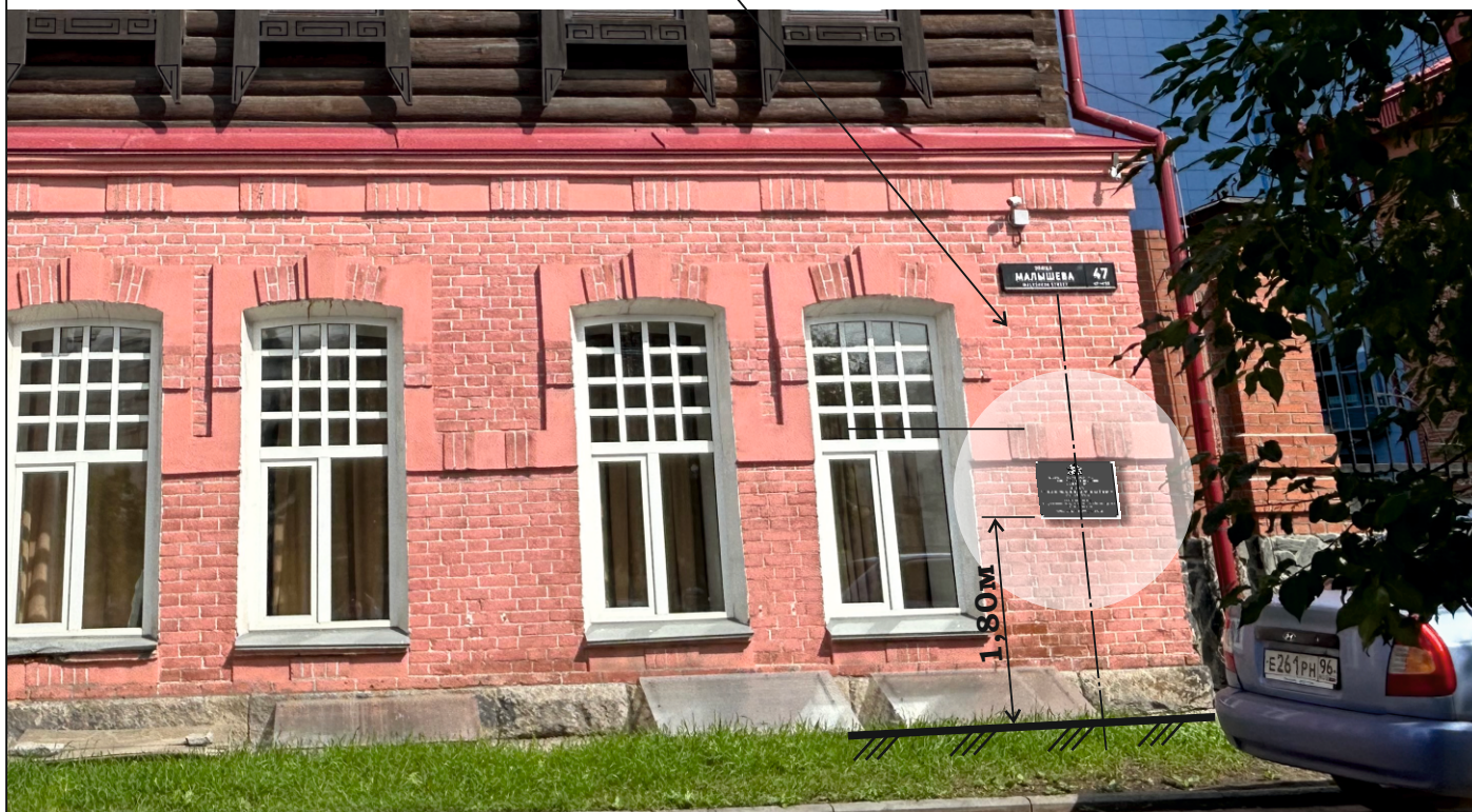
Фрагмент фасада со стороны ул. Малышева
