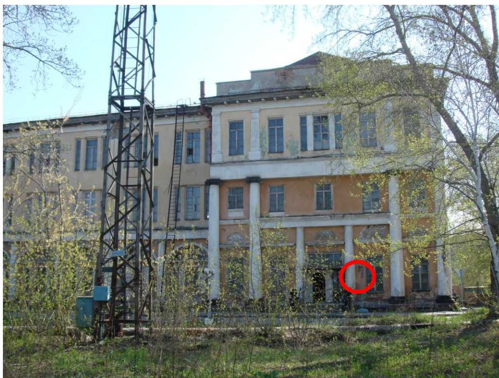
Фото-2. Главный западный фасад. Главный вход, справа указано месторасположения таблички
