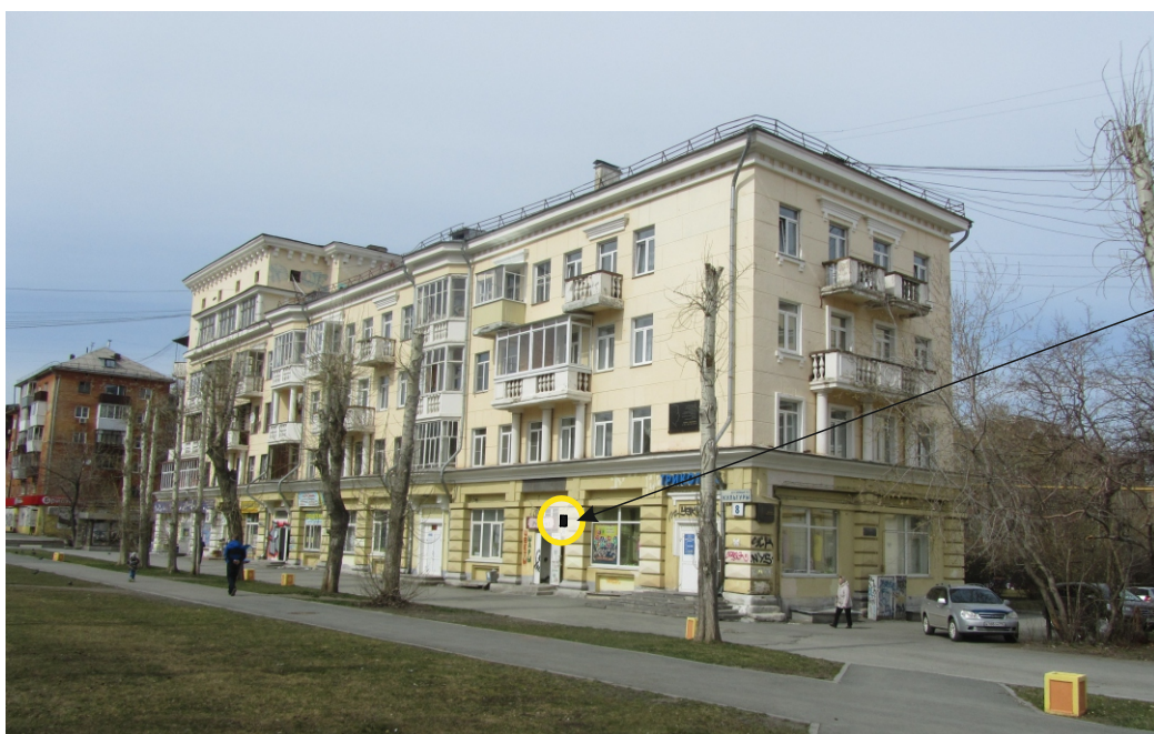
Фрагмент южного фасада объекта (ул. Культуры, д. 8)
