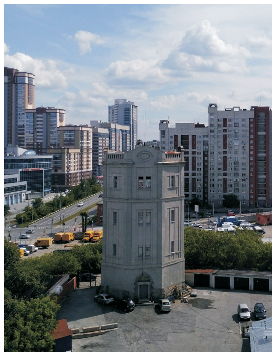
Общий вид со стороны перекрёстка Малышева-Московская
