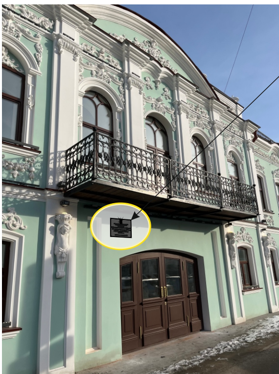
Фрагмент фасада со стороны ул. Попова
