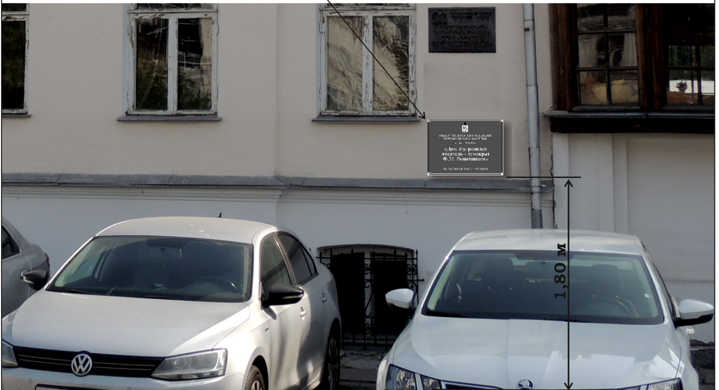
Фрагмент со стороны ул. Пролетарская
