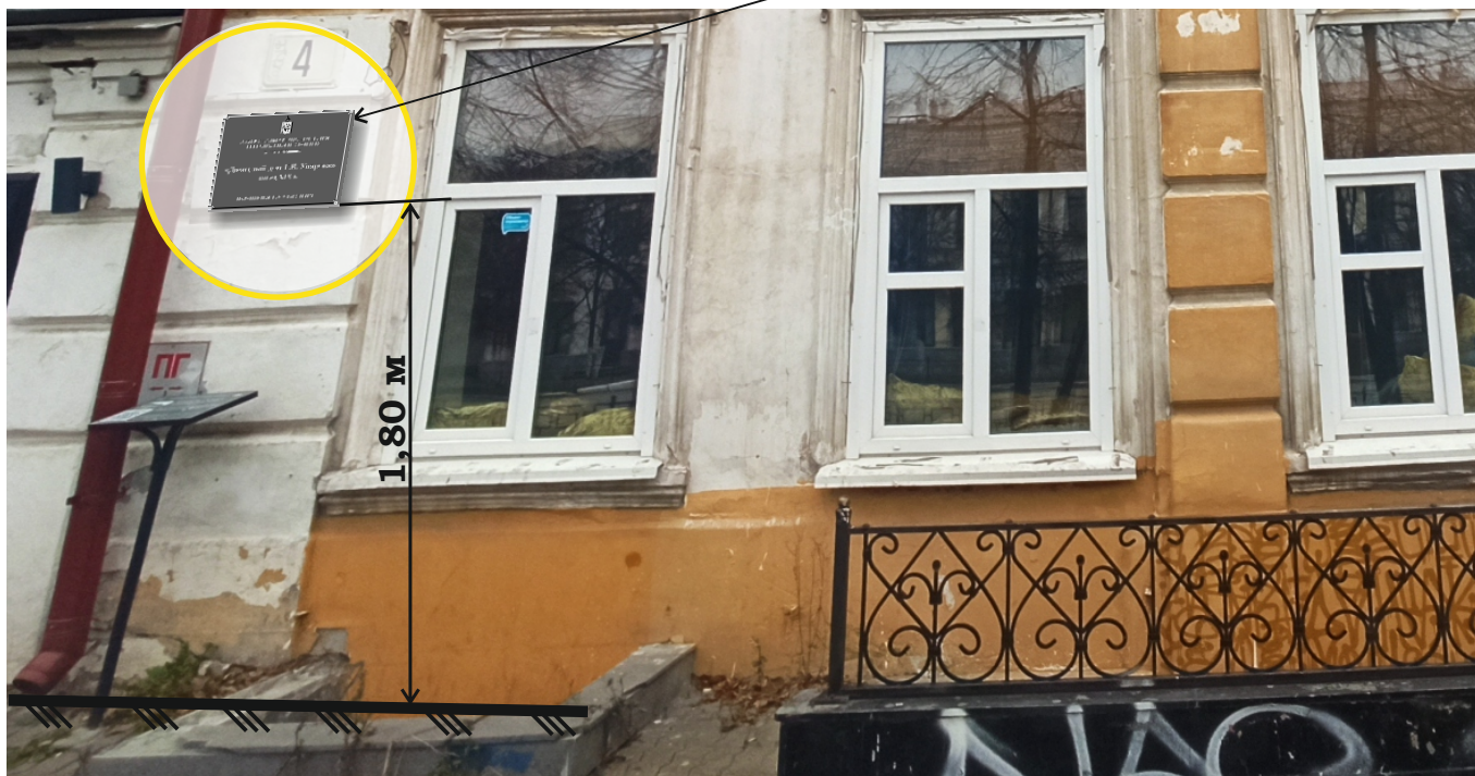
Фрагмент фасада со стороны улицы Пушкина.
