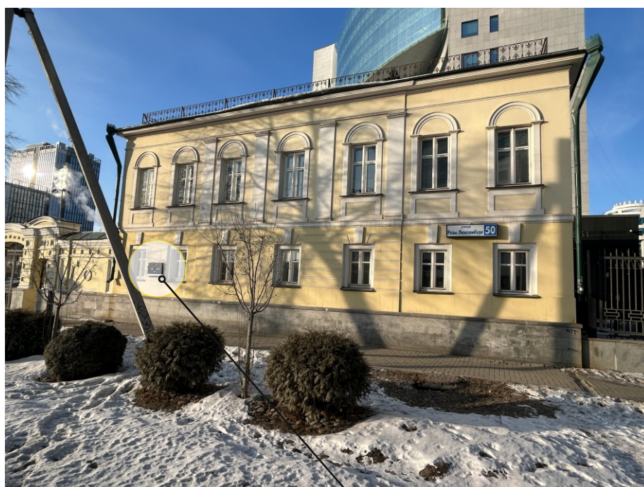
Общий вид ОКН «Дом» со стороны ул. Розы Люксембург.
