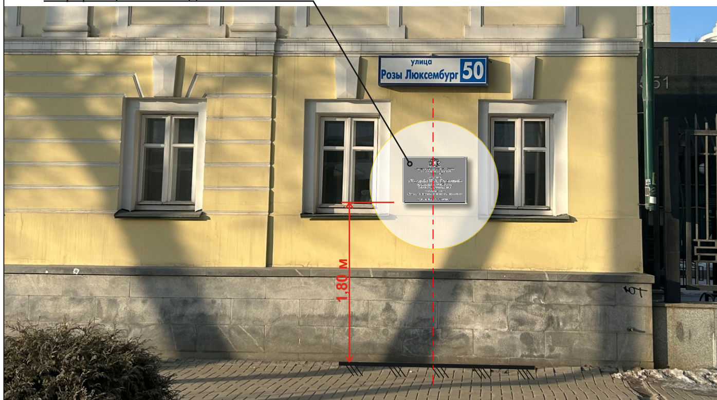
Фрагмент восточного (главного) фасада ОКН «Дом» со стороны ул. Розы Люксембург.
