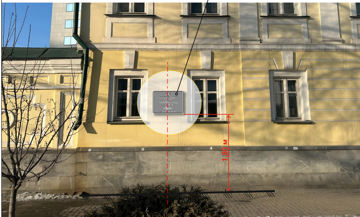
Фрагмент восточного (главного) фасада ОКН «Дом» со стороны ул. Розы Люксембург.
