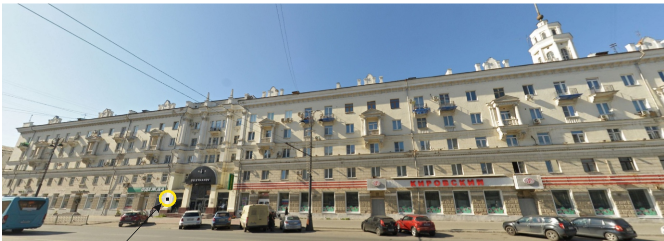
Общий вид «Дом жилой с башней», ул. Свердлова, д. 27, вид со стороны ул. Свердлова
