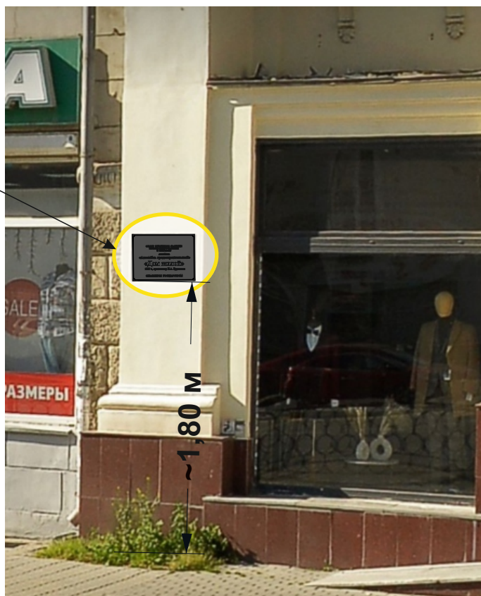
«Дом жилой с башней».Фрагмент фасада со стороны ул. Свердлова
