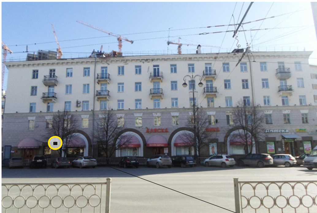
Общий вид «Дом жилой», ул. Свердлова, д. 22, вид со стороны ул. Свердлова
