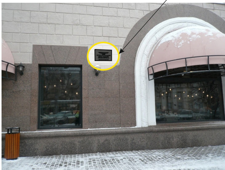
«Дом жилой».Фрагмент фасада со стороны ул. Свердлова
