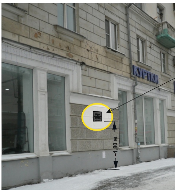
«Дом жилой».Фрагмент фасада со стороны ул. Свердлова
