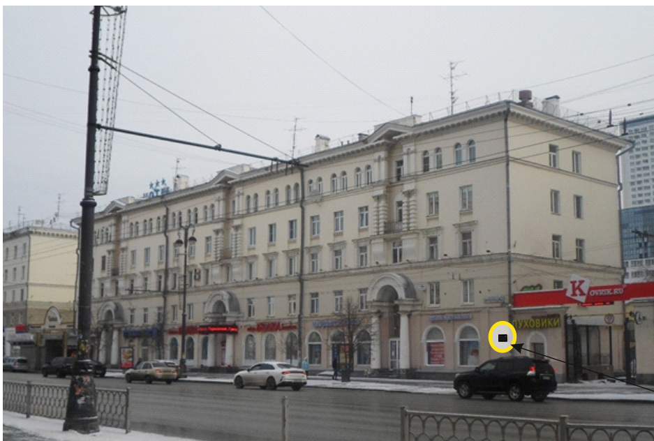
Общий вид «Дом жилой», ул. Свердлова, д. 62 вид со стороны ул. Свердлова
