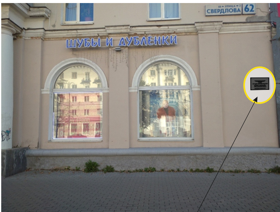
«Дом жилой». Фрагмент фасада со стороны ул. Свердлова
