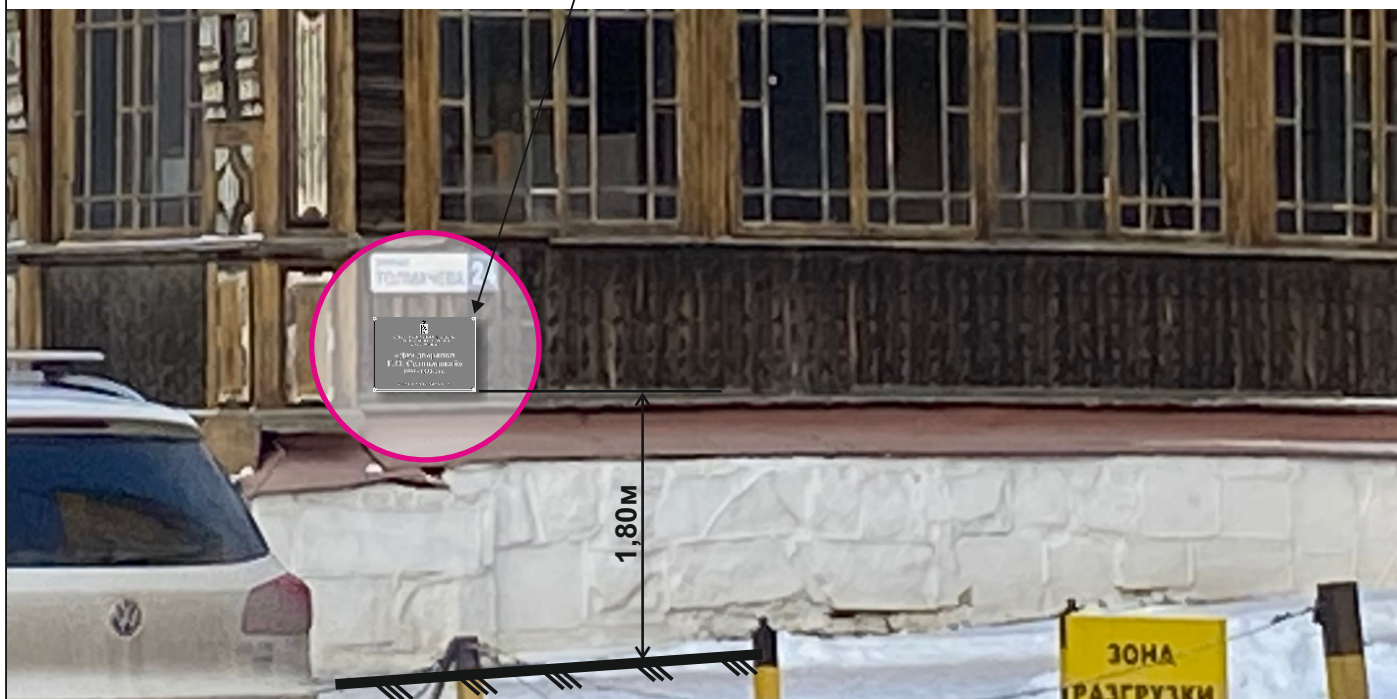
Фрагмент бокового (южного) фасада.
