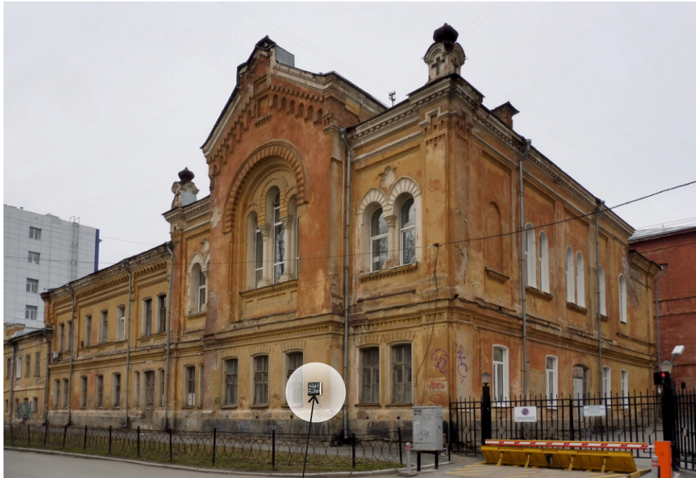
Общий вид объекта со стороны ул. Толмачева
