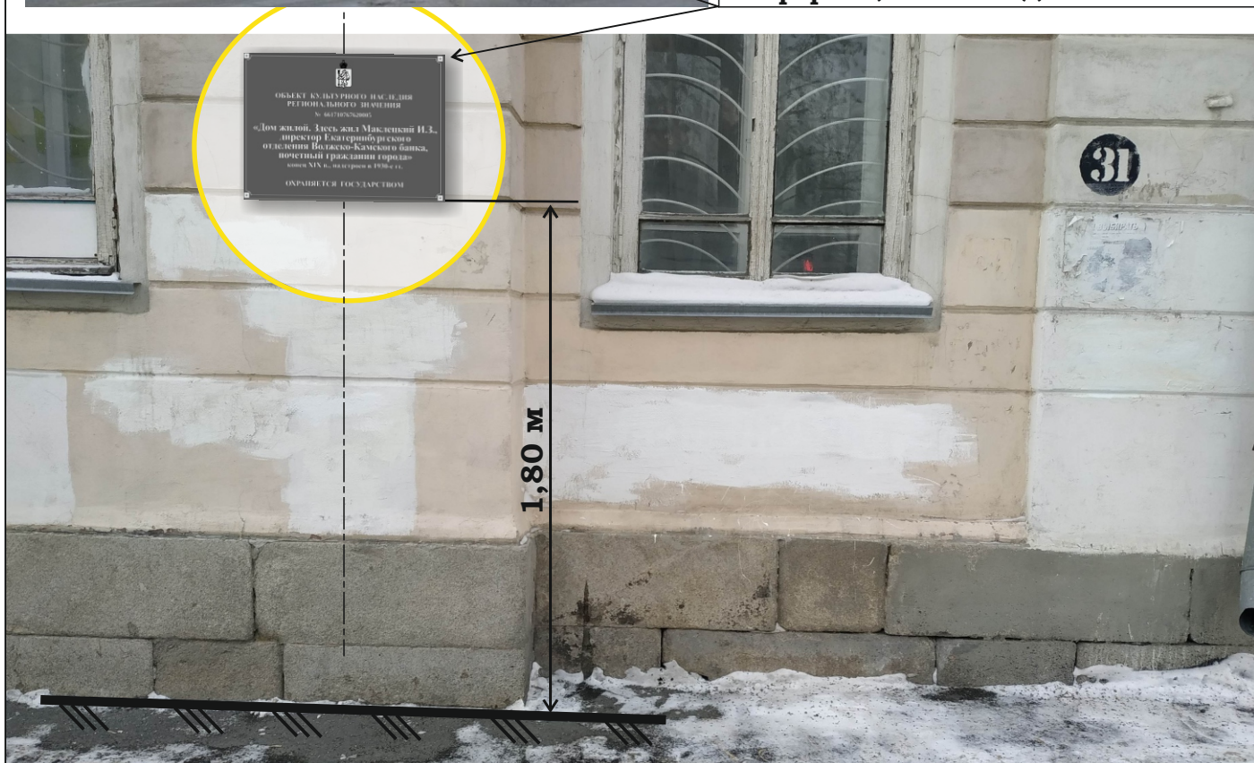
Фрагмент фасада со стороны улицы Тургенева
