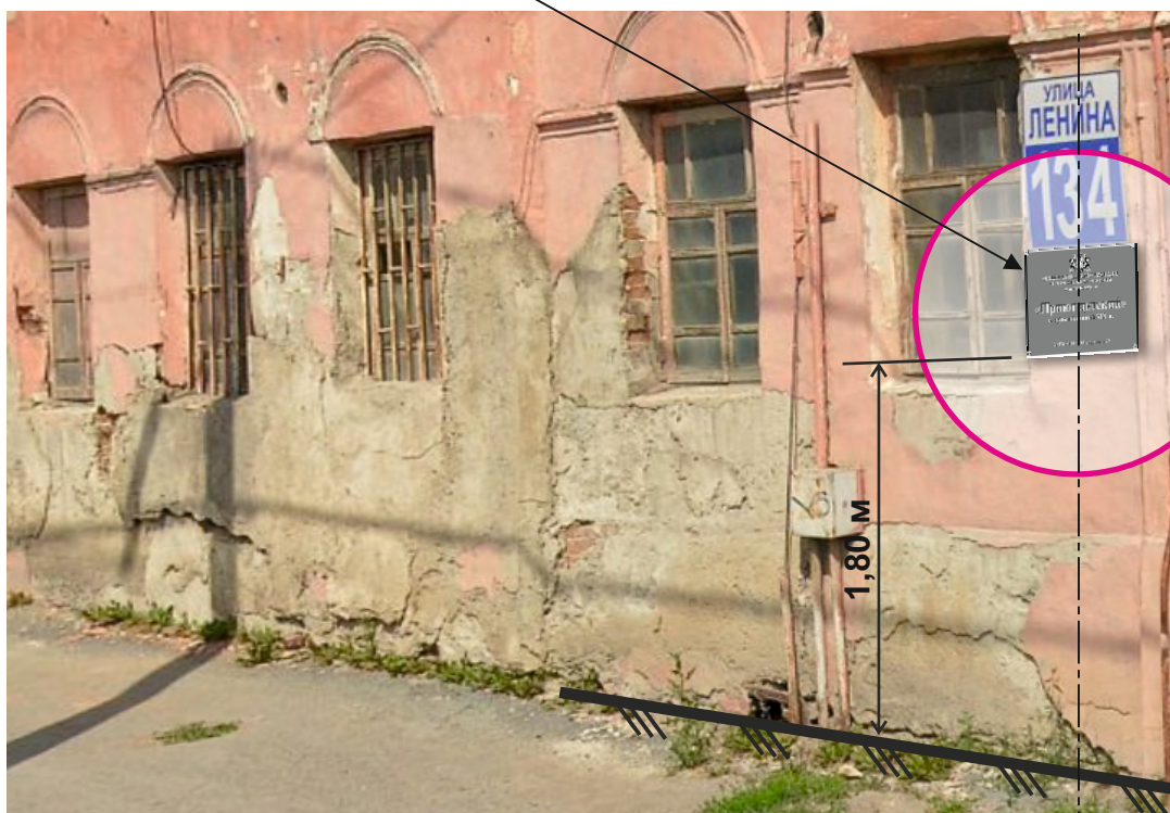
Фрагмент южного фасада со стороны улицы Ленина.
