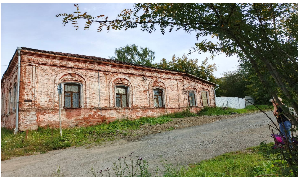
Общий вид с юга на главный (юго-восточный) фасад Объекта
