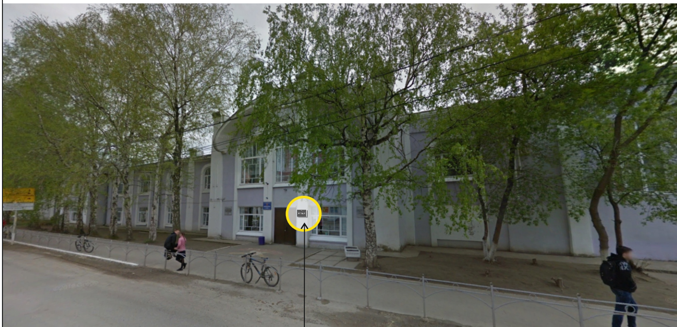
Общий вид с улицы Карла Маркса.
