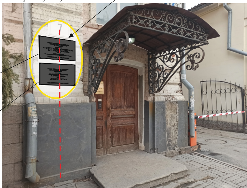
Фрагмент фасада со стороны ул. Пушкина
