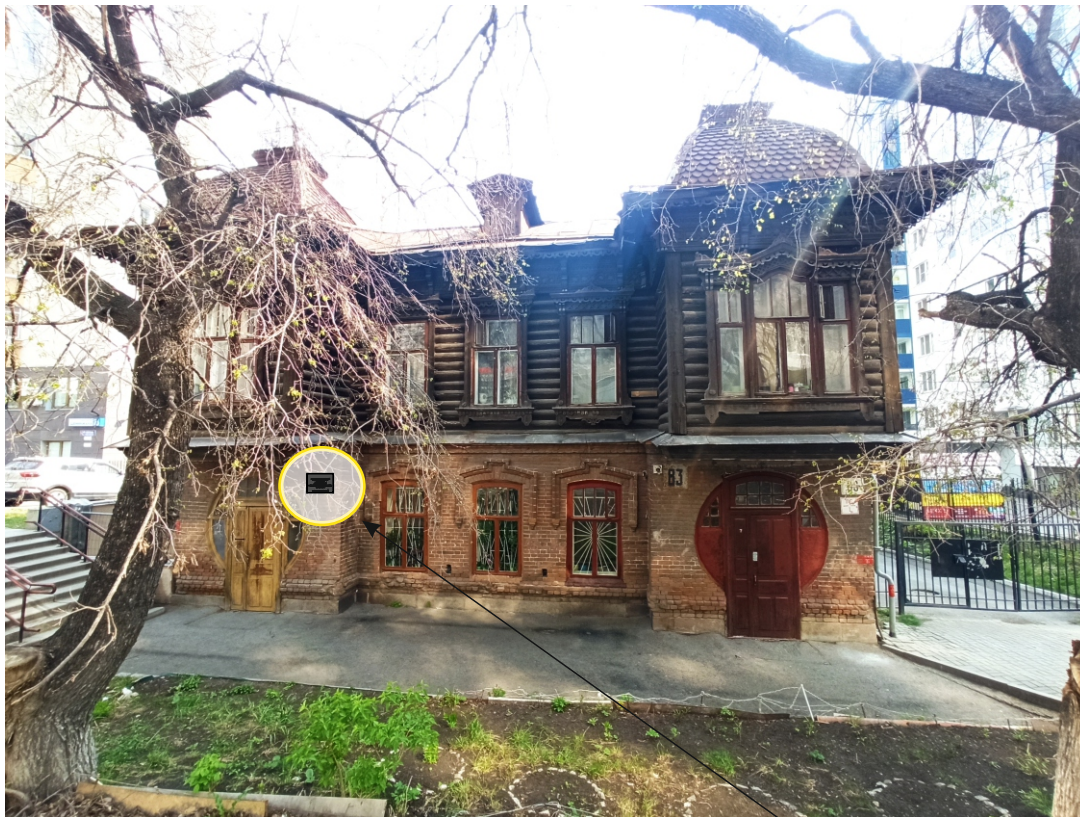
Общий вид памятника со стороны ул. Шейнкмана
