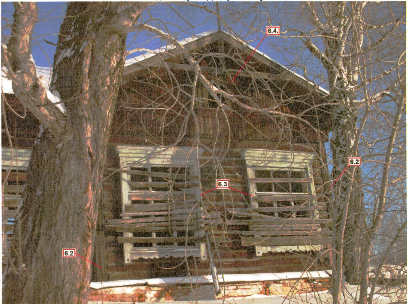
Юго-западный фасад. Правый ризалит
