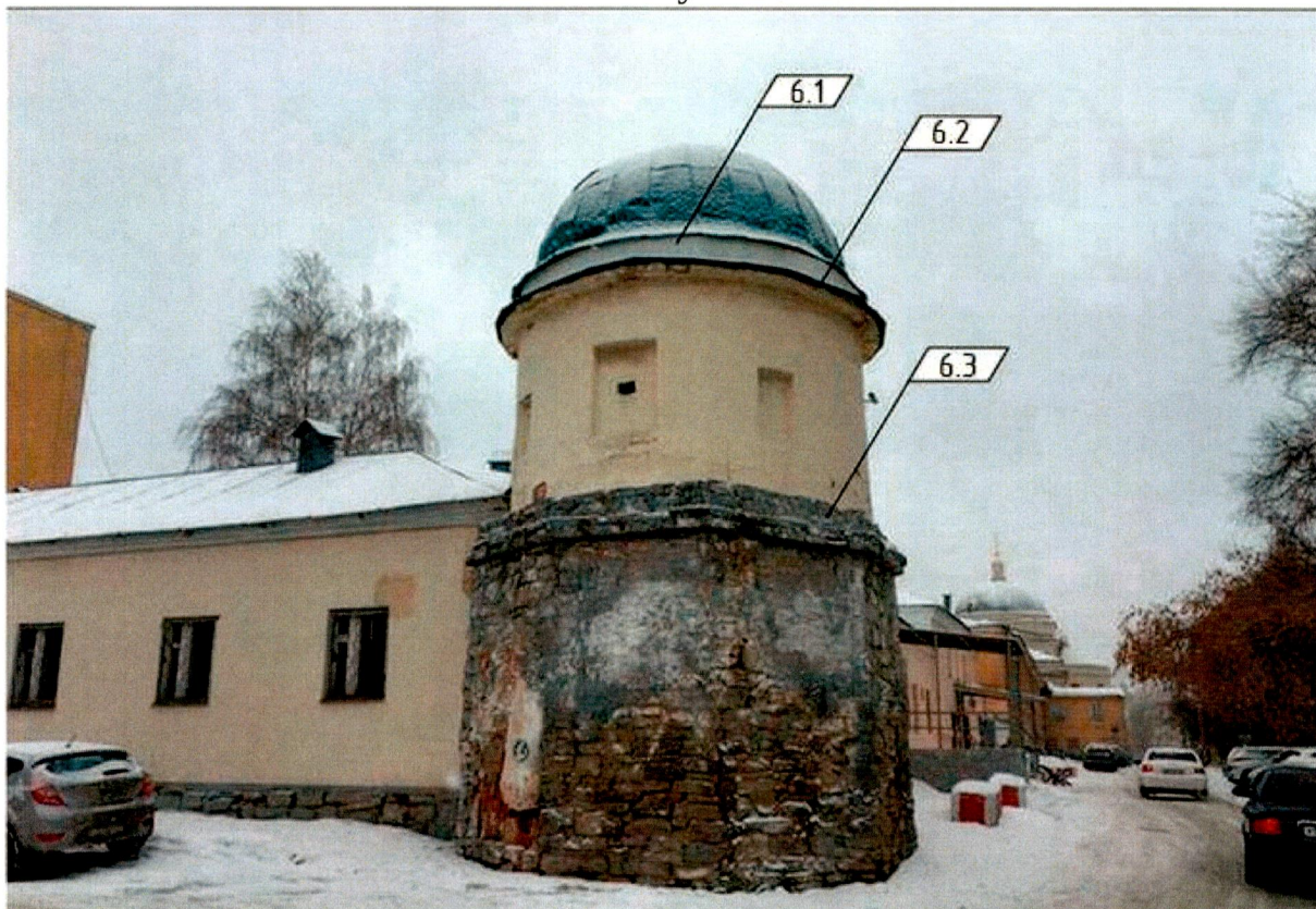
Юго-восточная угловая башня
