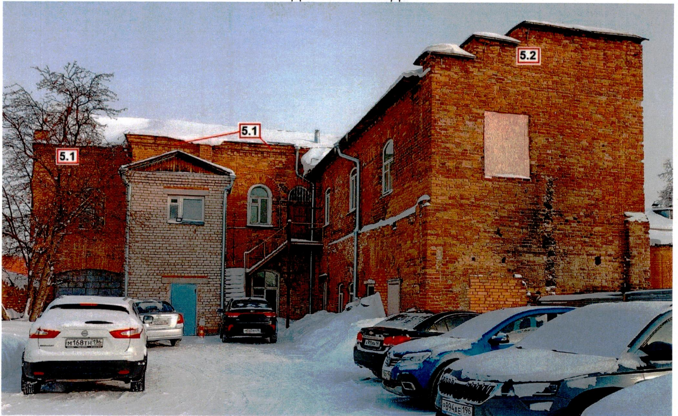
Вид с юго-запада
