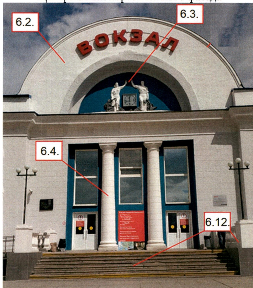
Центральный портал южного фасада
