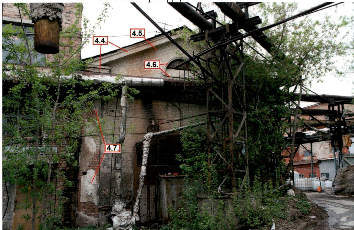
Восточный фасад цеха механического
