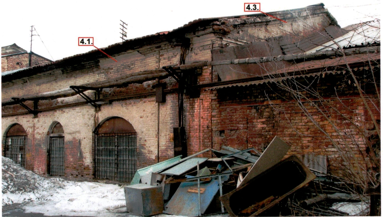
Фрагмент северо-западного фасада литейного двора
