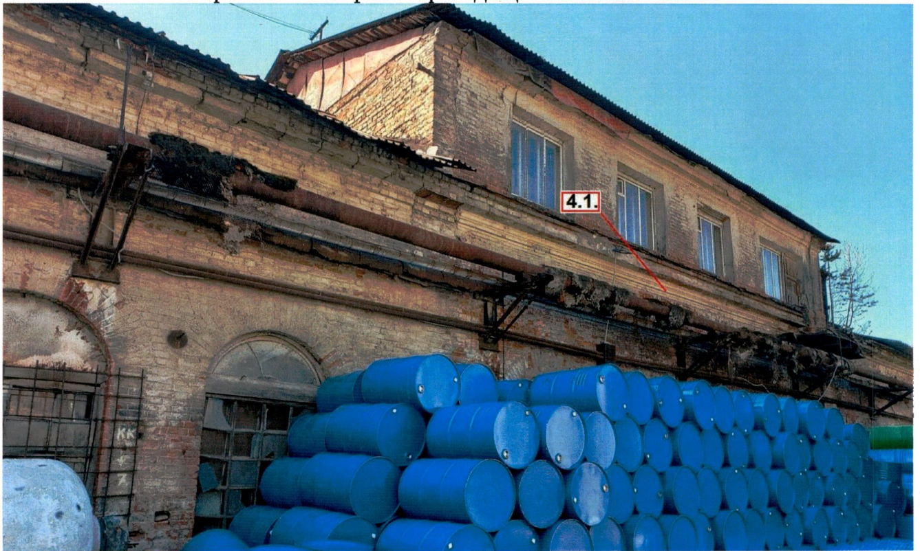
Фрагмент северного фасада цеха механического
