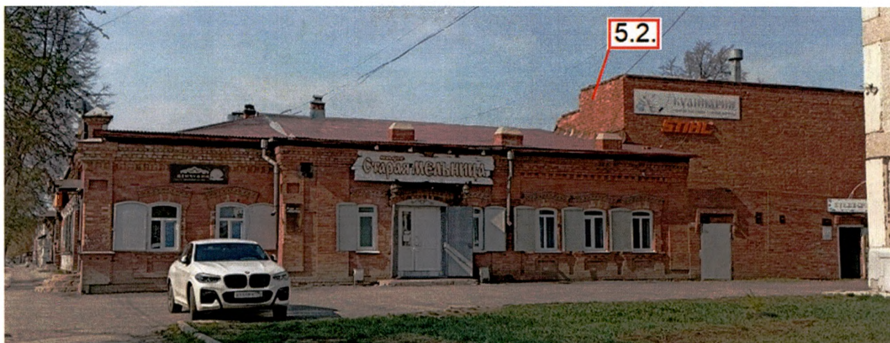
Вид с северо-запада (правая часть)
