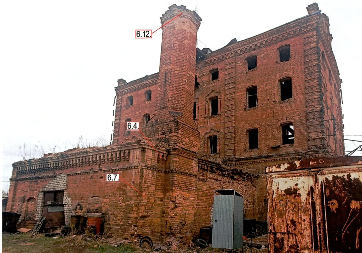
Северо-восточный фасад юго-восточного пристроя
