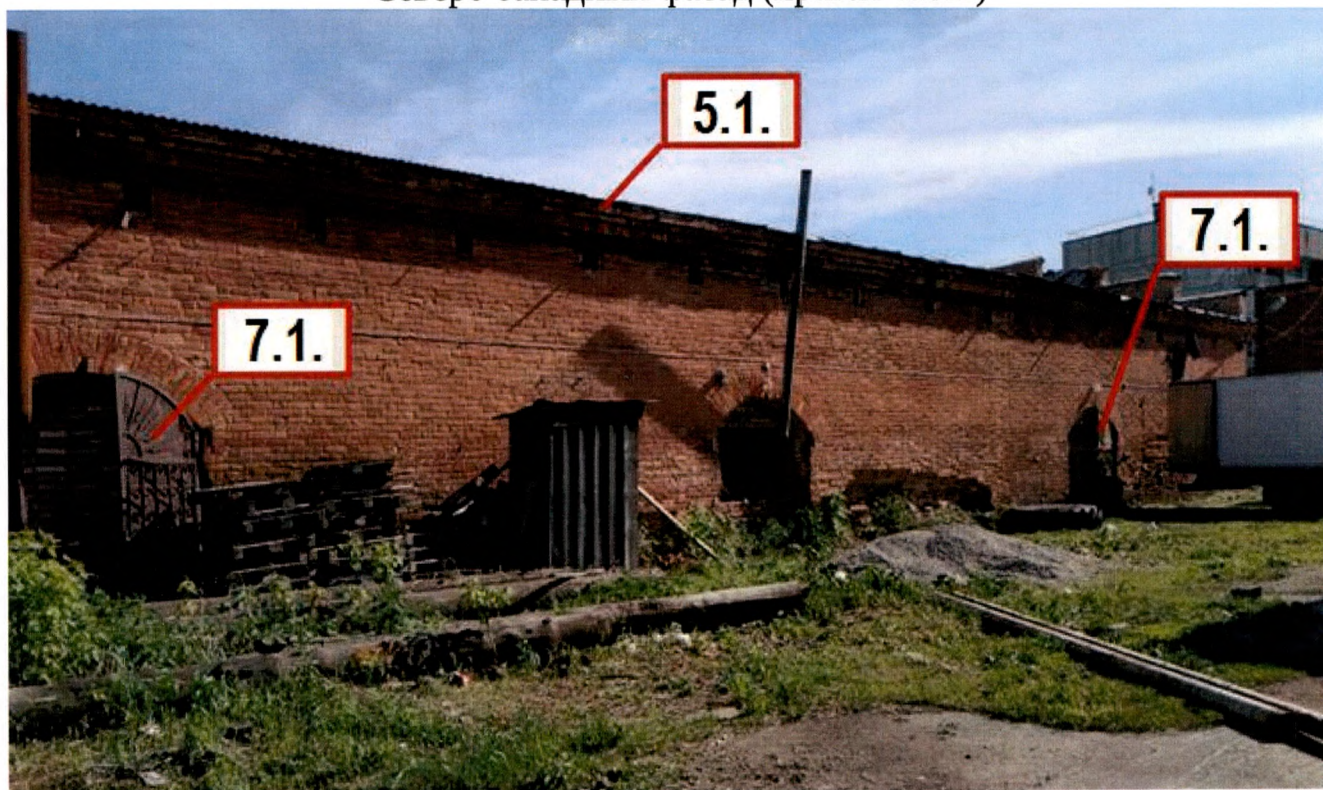
Северо-западный фасад (правая часть)
