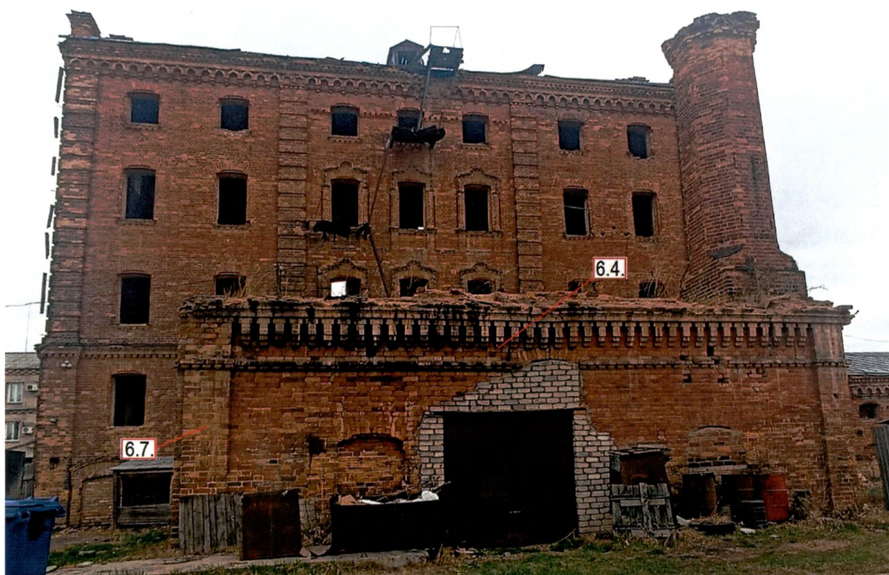
Юго-восточный фасад юго-восточного пристроя
