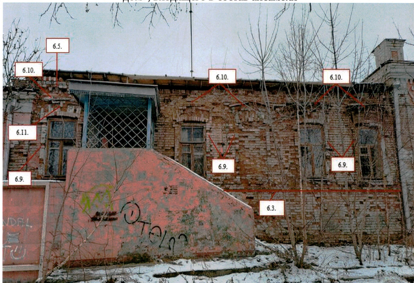
Западный фасад основного объема «Бывший теплый пристрой» объекта «Жилой дом», входящего в состав ансамбля
