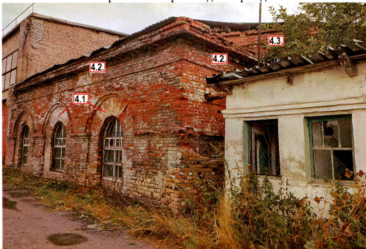
Фрагмент северо-западного фасада
