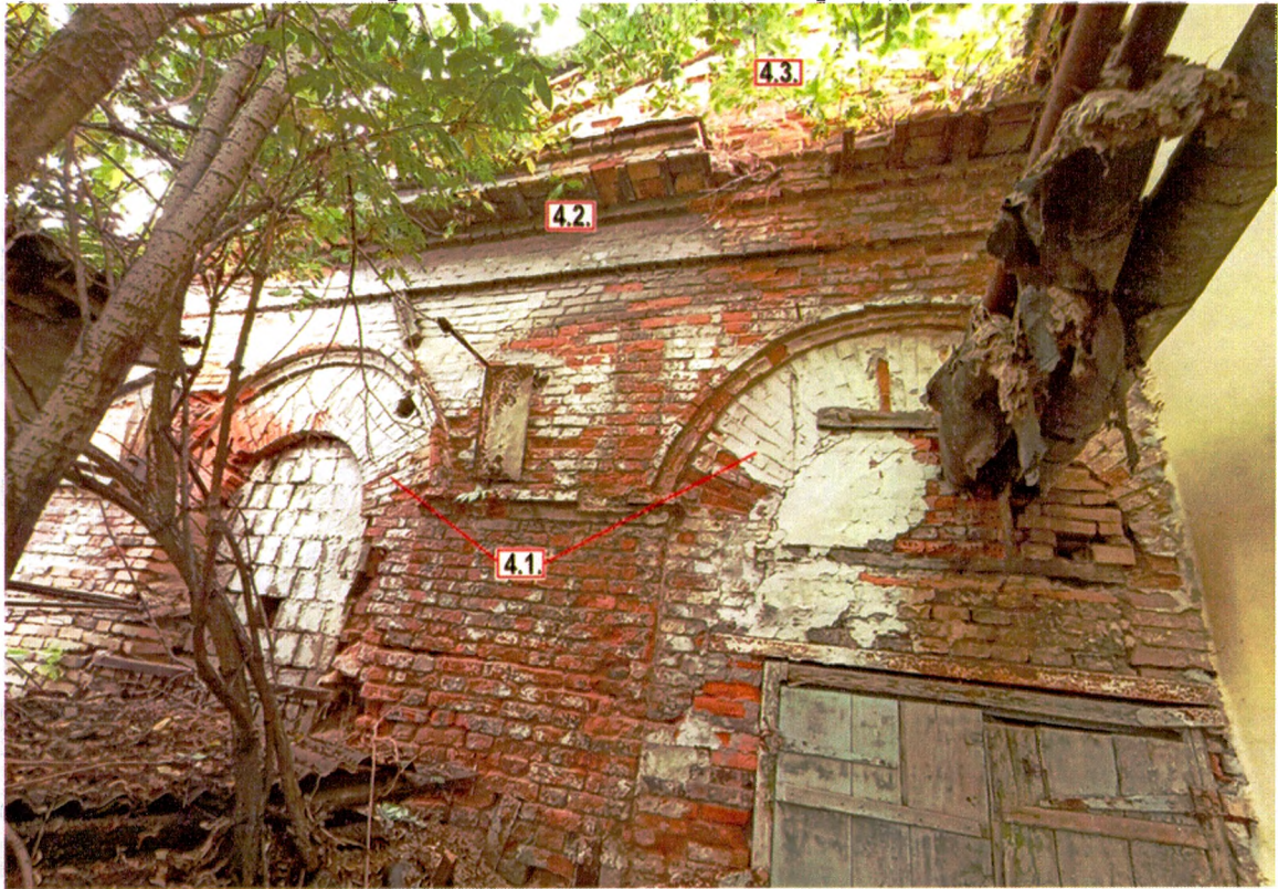
Фрагмент юго-западного фасада
