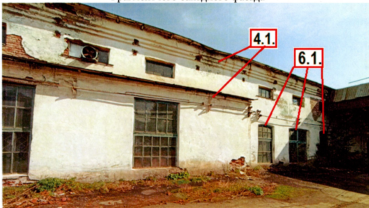
Фрагмент юго-западного фасада
